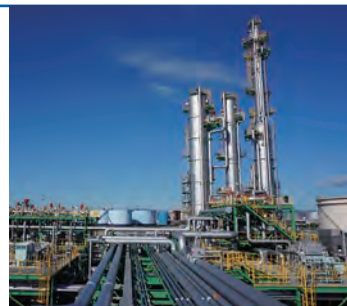
苫小牧CCS実証プラント
