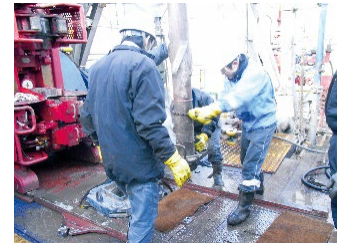
調査井掘削の様子
