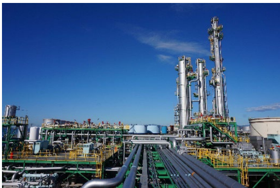
苫小牧CCS実証試験センター
