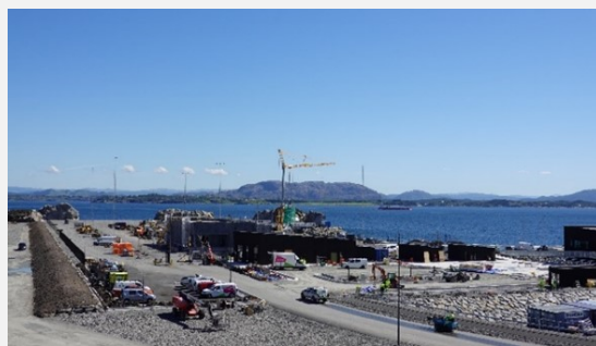
Northern Lights プロジェクト建設現場 2022年6月
