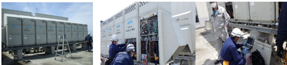
室外機外観点検風景
