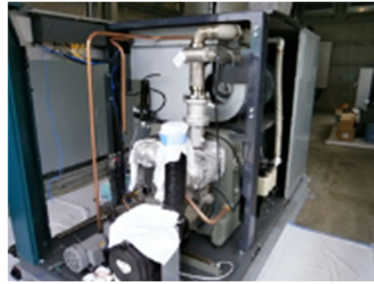
計装空気圧縮機整備
