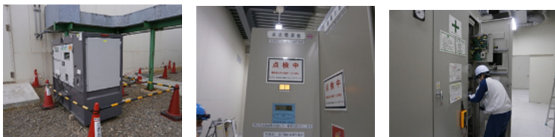
仮設発電機設置
