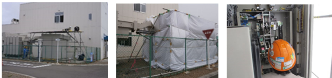
屋外機器 (C-GIS) 点検のための雨養生
