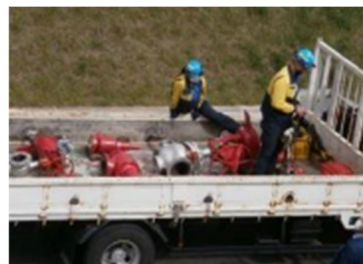
点検検査のため工場搬出
