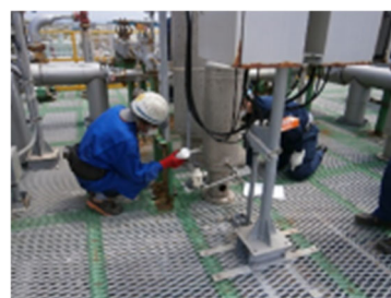
空気ホルダー回り漏洩確認
