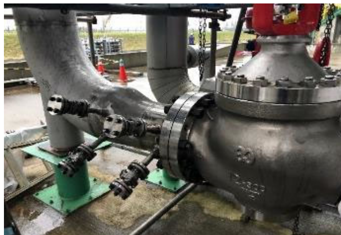
図 12.2-3 テストプローブ取り付け用治具の設置状況
