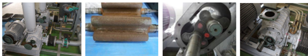
整備前ブロアー 錆びたルーツ 整備後ルーツ組込み ルーツ組込み完了
