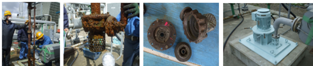
縦型ポンプ取り外し 整備前 整備後 組付け完了
