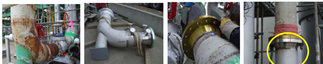
既設炭素鋼配管 交換後ステンレス鋼配管 新規フランジ設置 溶接施工部の焼鈍処理
