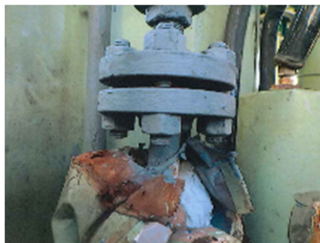
フランジ取替後
