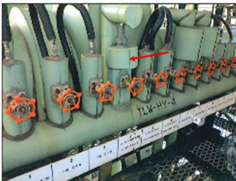
保温復旧完了後
