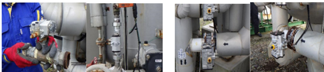
交換前 交換後 交換前 交換後
