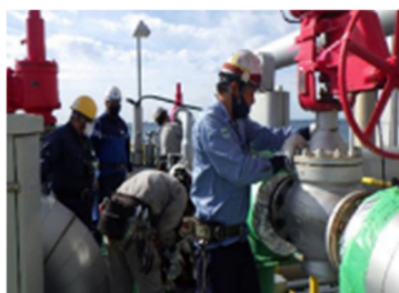
調節弁取り外し
