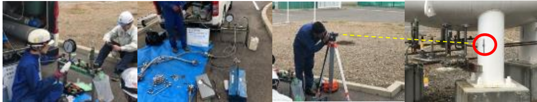
安全弁設定圧力検査
