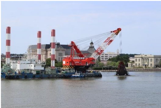
図 4.2-44 グラブ浚渫作業の例
