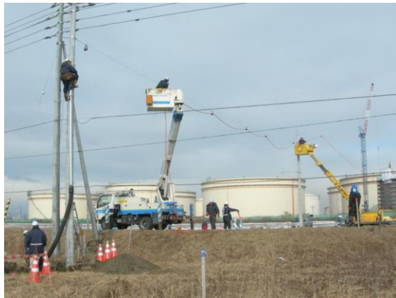
図 4.2-39 高所作業車を用いた作業状況 (設置時)
