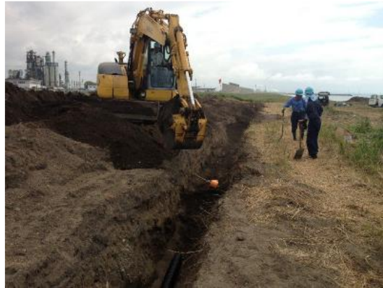
図 4.2-40 重機（バックホウ）による掘削状況（設置時）
