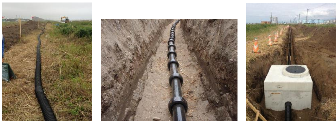
（左：FEP 保護管、中：铸铁保護管、右：OBS 用ボックスカルバート）
