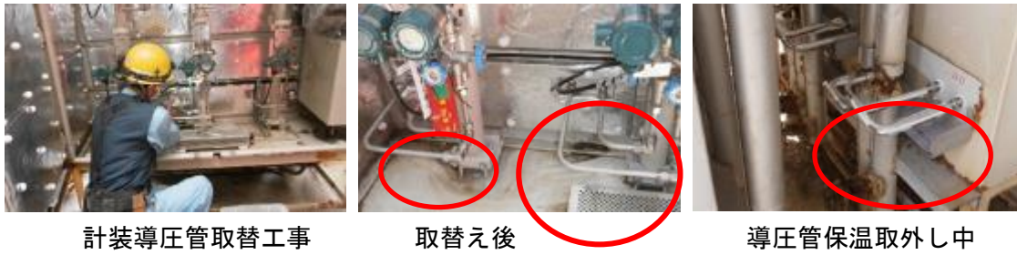
図 2.2-4 (1) 差圧伝送器導圧管変形補修
