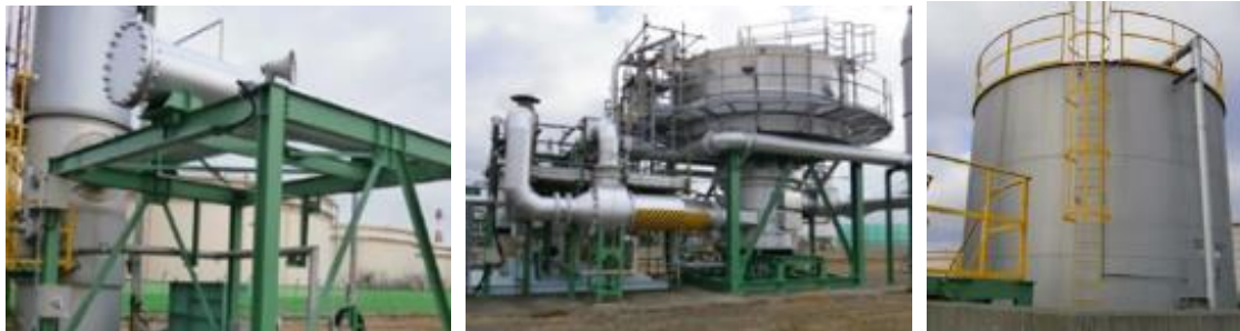
フレア設備架構・配管塗装
