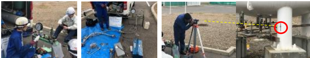
安全弁設定圧力検査 フレキホース耐圧試験 不同沈下測定
