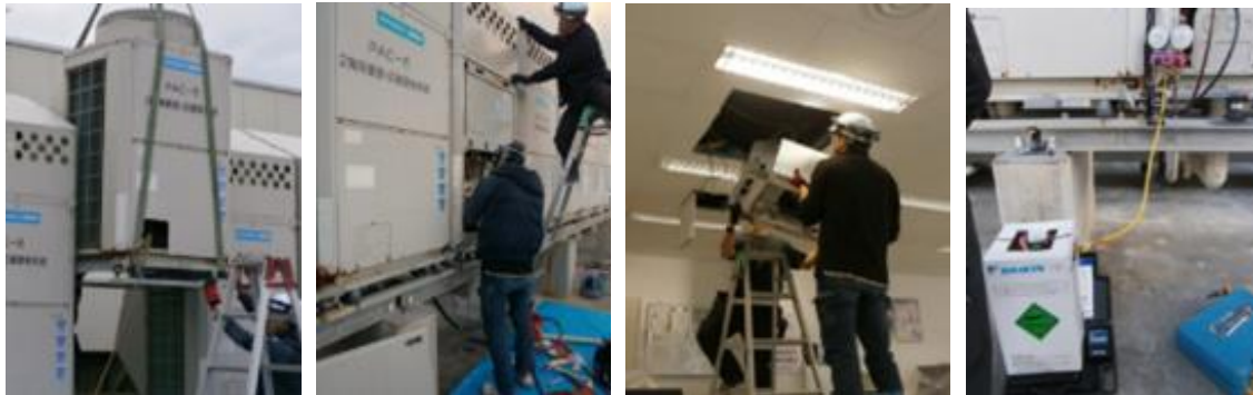
既設室外機撤去
