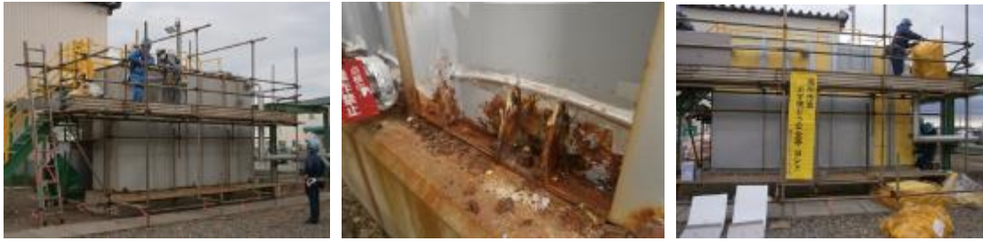
足場架設保温解体撤去
