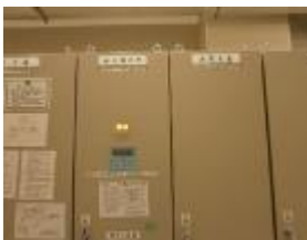
直流電源装置の点検
