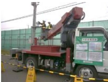
高所作業車で監視カメラ点検整備
