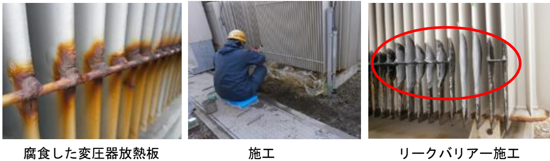
図 2.2-4 (2) 変圧器絶縁油滲み漏れ補修
