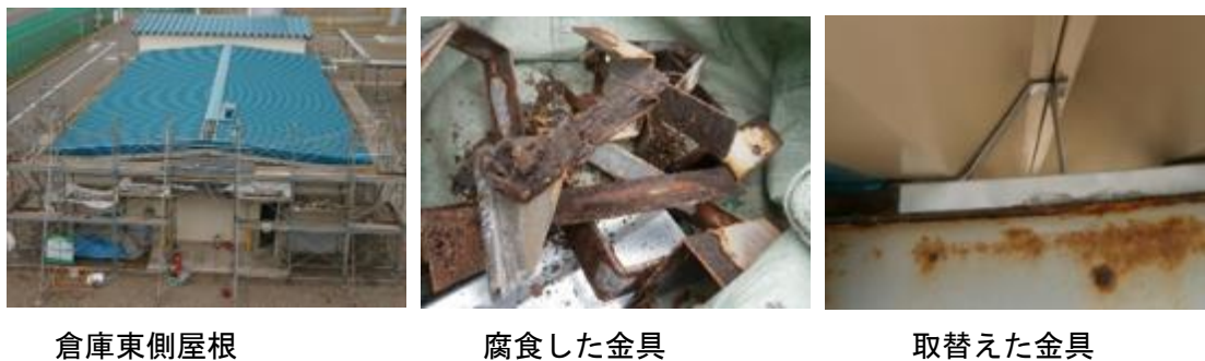
図 2.2-4 (3) 部品倉庫屋根折板固定用端部タイトフレーム補修
